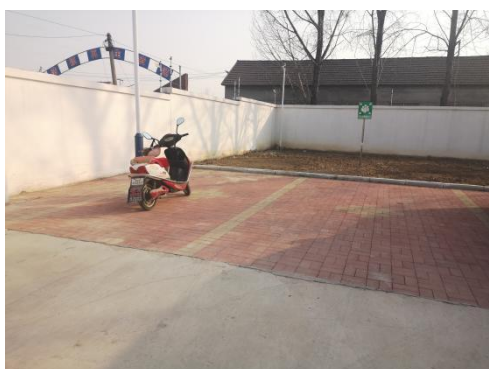
升压站透水砖
