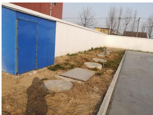
升压站绿化及排水
