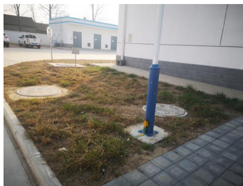
升压站绿化及排水
